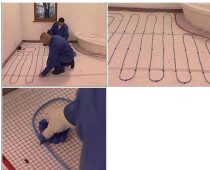
Отметка «SPLICE» говорит о месте соединения теплового кабеля с электрическим. Следите за тем, чтобы это место было расположено в зоне цементной стяжки и как можно ближе к месту подключения термостата. Расстояние до ближайшей стены не должно быть менее 20 – 30 см, а сам отрезок соединения непременно должен оставаться прямым и не подвергаться перегибу во избежание ненужных трещин или переломов этого важного узла.
