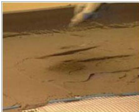
Закончив заливку песчано-цементным раствором, снова следует проверить электротестером целостность кабеля и только при отсутствии неполадок оставить стяжку на время застывания. Заствшую стяжку покрывают напольным покрытием – ламинатом, кафельной или каменной плиткой, линолеумом. Ламинированный паркет, паркетную домку или любой натуральный пол следует выбирать с осторожностью,
