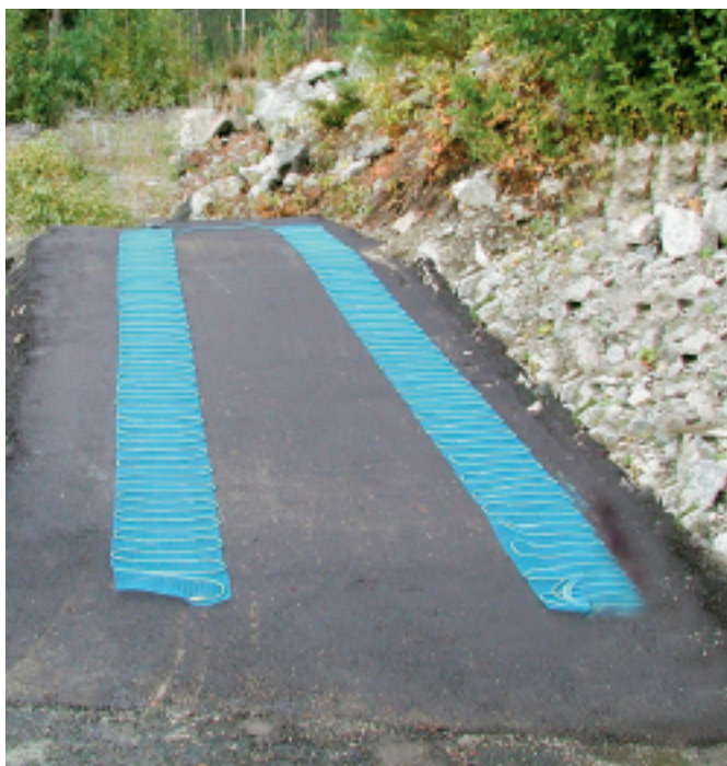
Установка кабельной сетки SNOWMAT
