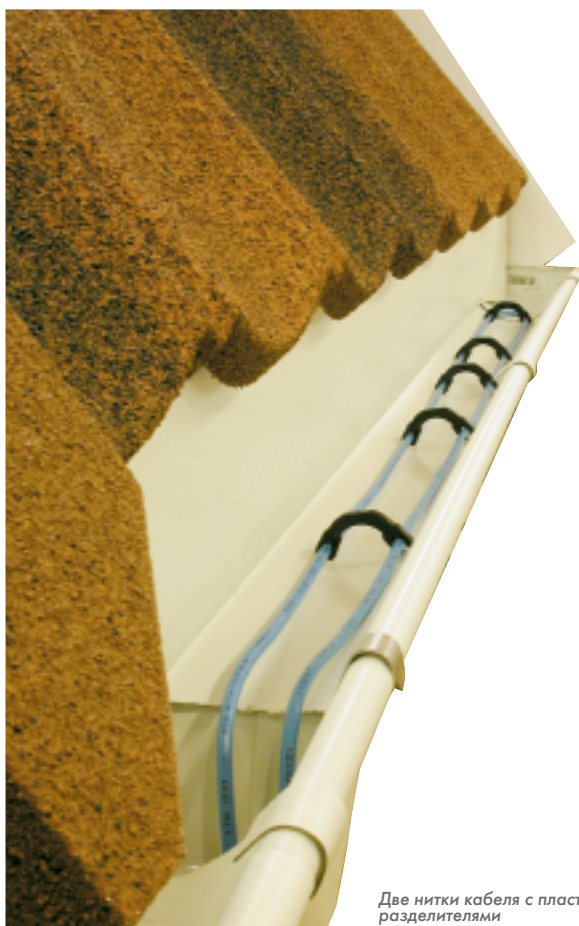
Две нитки кабеля с пластиковыми разделителями
