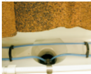
Подвеска из нержавеющей стали, закрепленная на верхней части водостока
