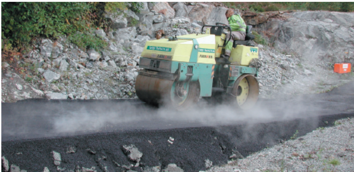
Утрамбовка покрытия после ручной засыпки асфальта
