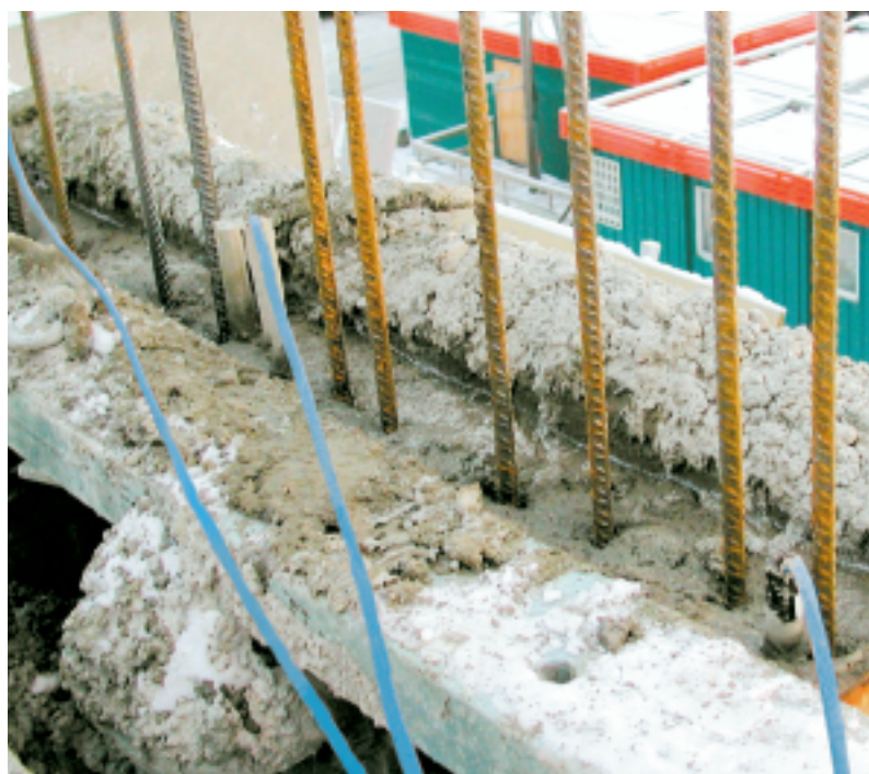
Нагревательный кабель после заливки бетона
