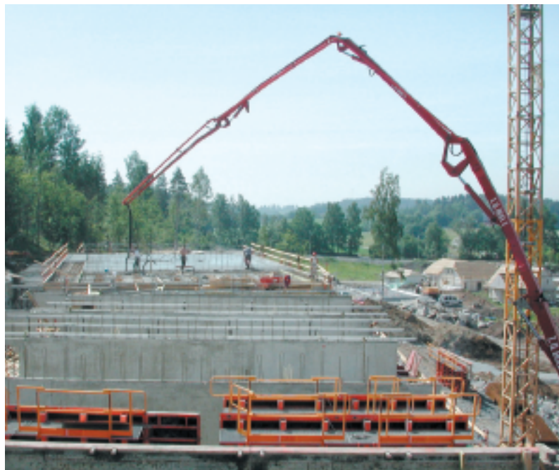
Строительная площадка в Осло
